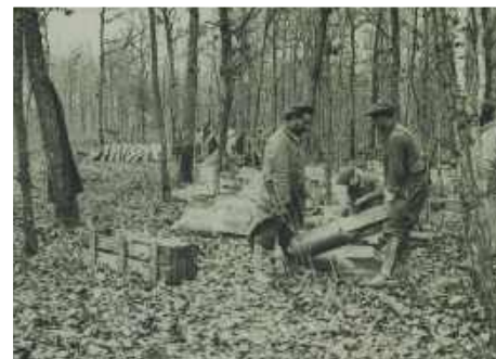
Près de la gare de Mortzwiller, à côté du ravitaillement. Soldats italiens employés à la construction d'une voie de 0.60
